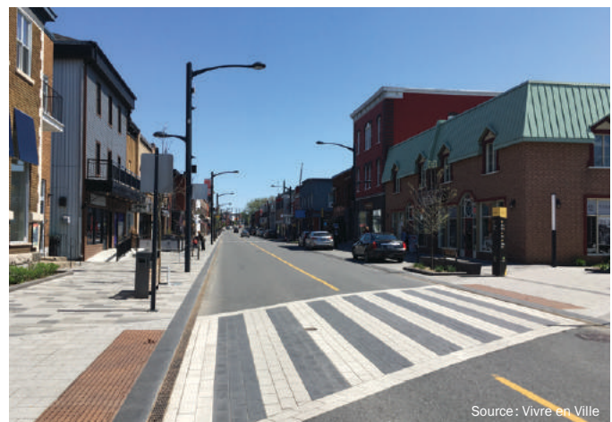
Figure 3.3.b TRAVERSE PIÉTONNE AVEC PLAQUE PODOTACTILE À VICTORIAVILLE
